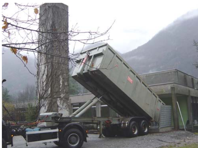
Il riempimento del silo del cippato di legna.
